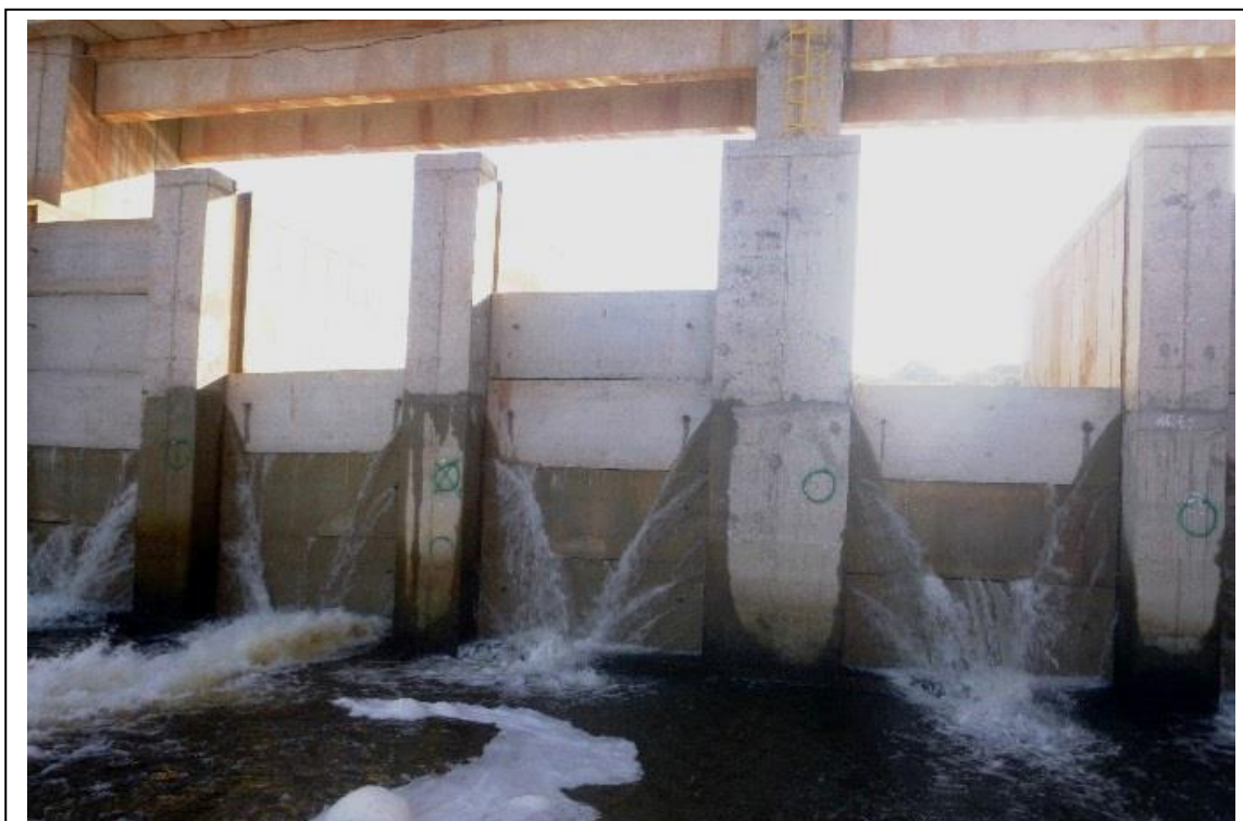
Figura 15: O procedimento de enchimento foi feito com a colocação de blocos de concreto
