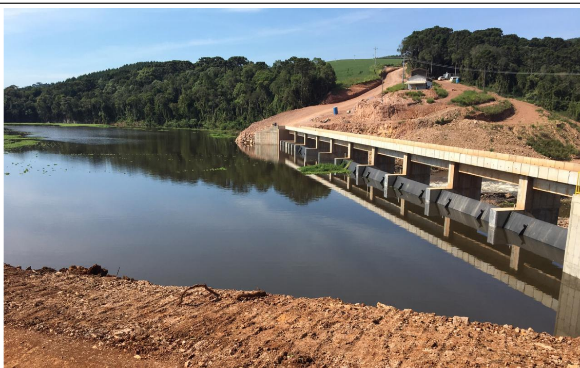
Figura 13 Barragem da PCH Pulo em processo de formação do reservatório.
