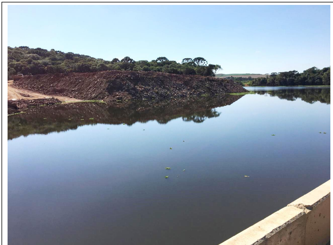
Figura 14: Vista do reservatório no final do enchimento
