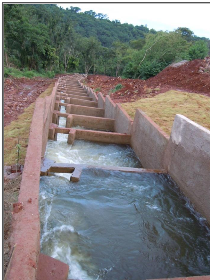
Figura 3 - Escada de Peixes PCH Santana I - Nortelândia-MT (45m de altura)
