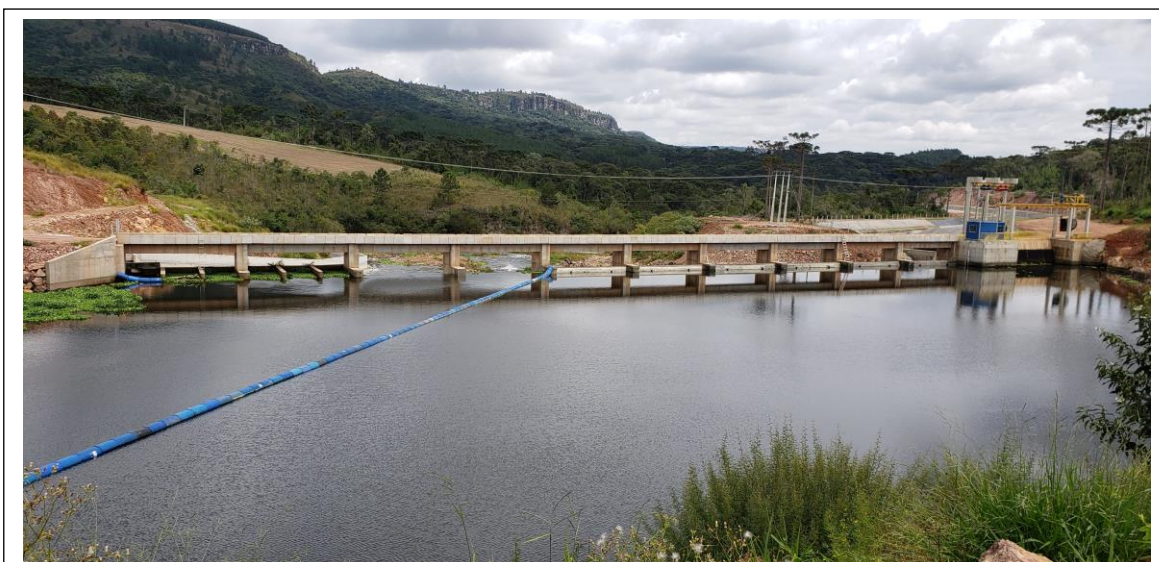
Fig. 2. Vista de montante da barragem, sobre a qual, a ponte de serviço que acessa a casa de força.
