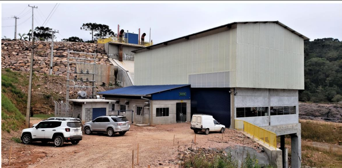
11. Casa de Força no início da operação, junho de 2019
