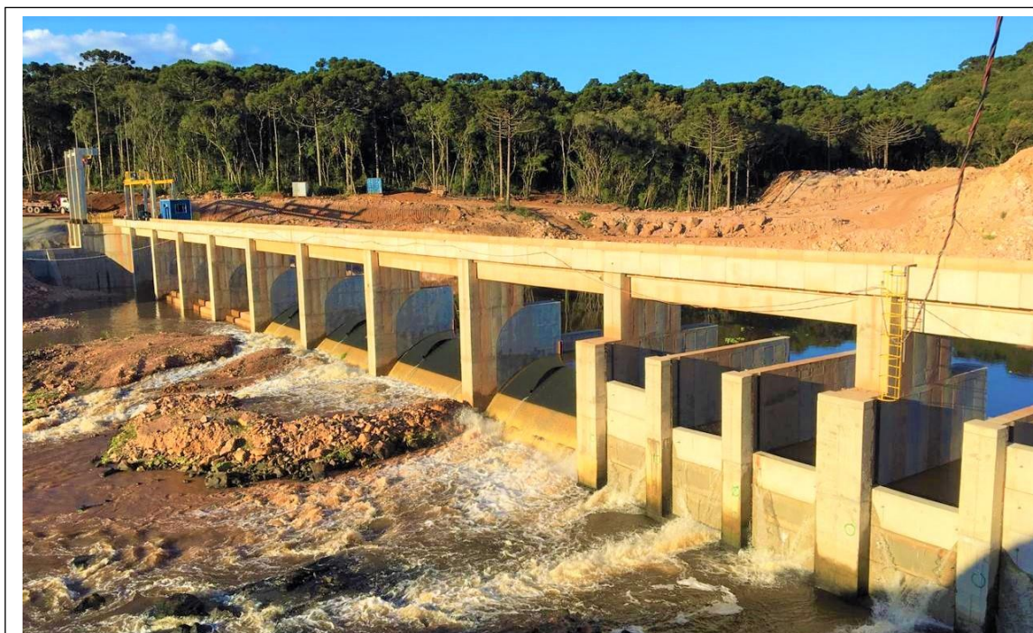
Fig. 2. Fechamento das estruturas da barragem, mantendo vazão ecológica pelas comportas basculantes
