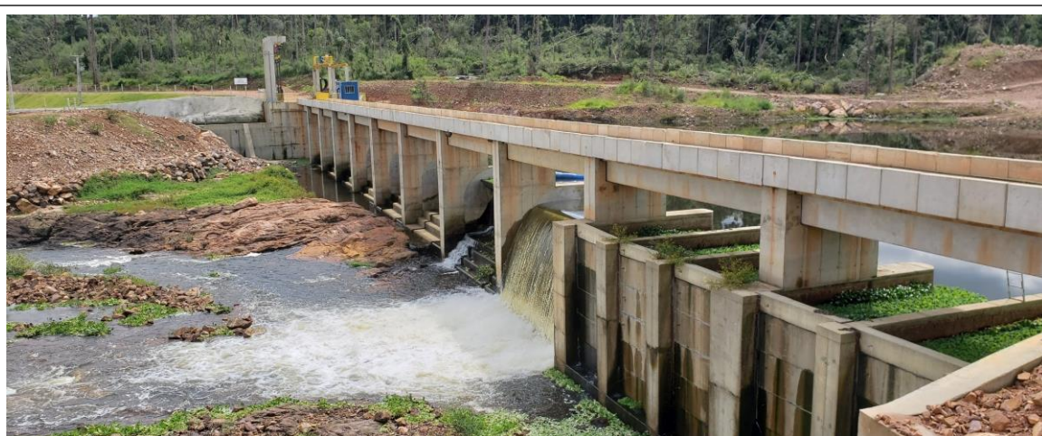
Fig. 01: PCH PULO vertendo pela comporta basculante em março de 2020
