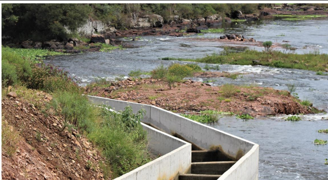
6. TVR e escada de peixes, em período de baixa vazão do rio.
