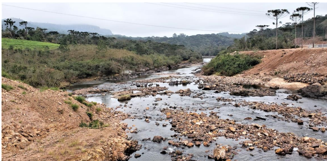
4. Rio Jaguariaíva no trecho de vazão reduzida – TVR, em junho de 2019
