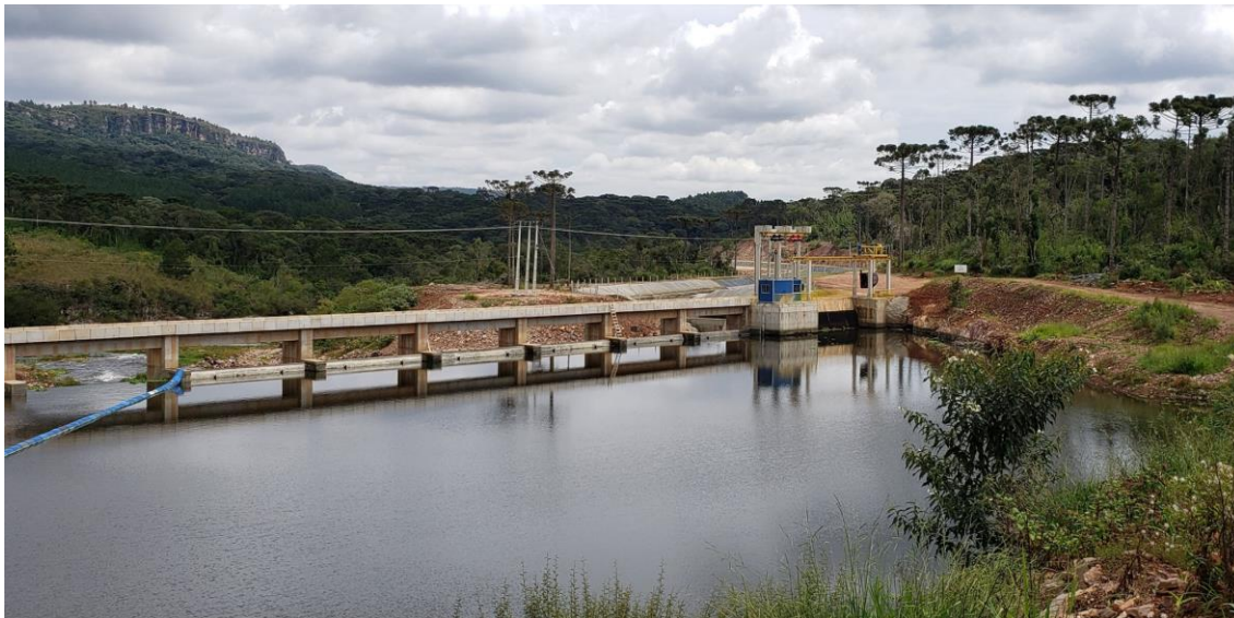
13. Ponte sobre barramento e início do canal adutor.
