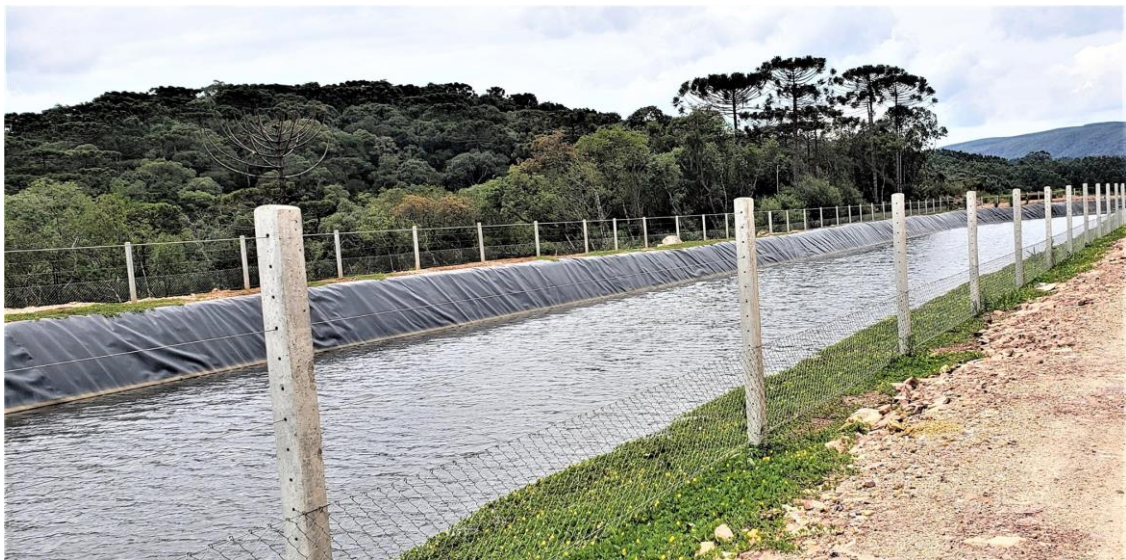
10. Canal adutor cercado, evitando a queda de animais e pessoas
