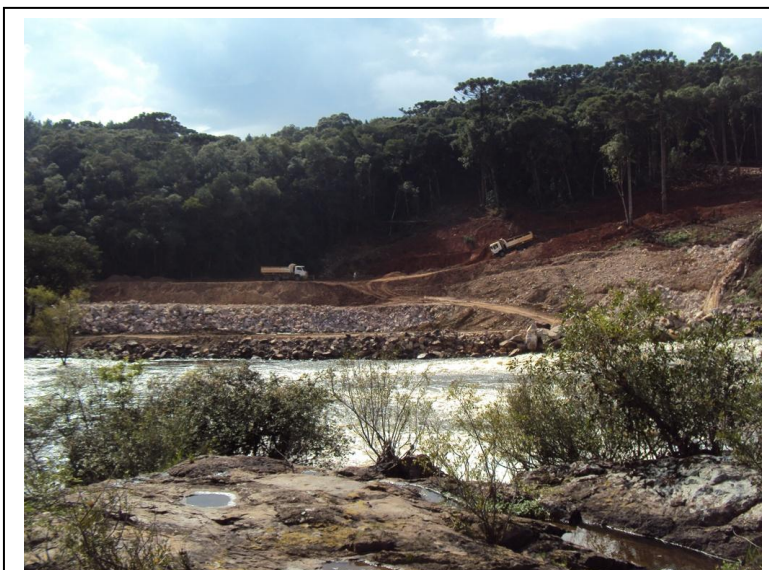
Figura 1 Canteiro de obras referente à construção da casa de força, na margem oposta do ponto amostral FT2.
