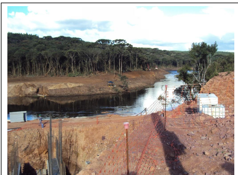
Figura 2 Desmatação da vegetação na margem da futura área do reservatório, registrado a partir do eixo de barramento.
