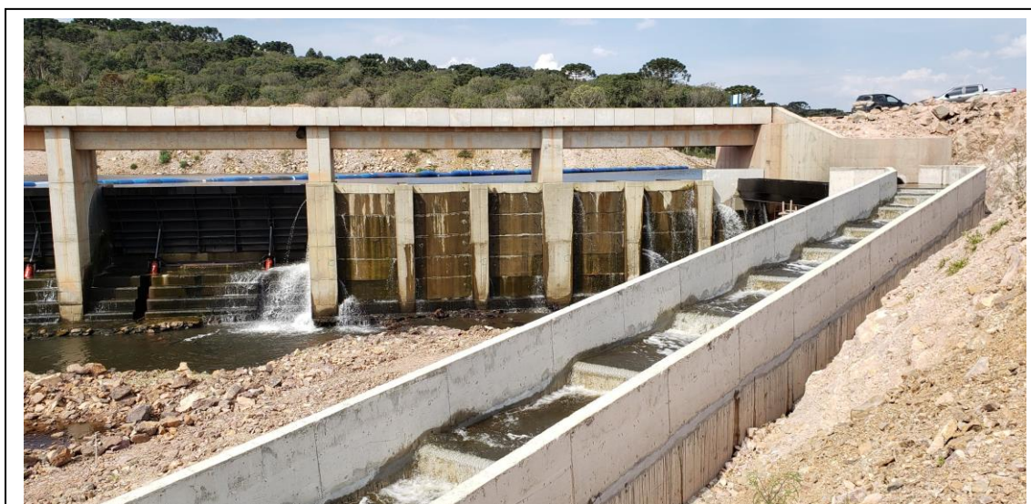
Dispositivo de migração da ictiofauna da PCH PULO, fluindo a vazão sanitária
