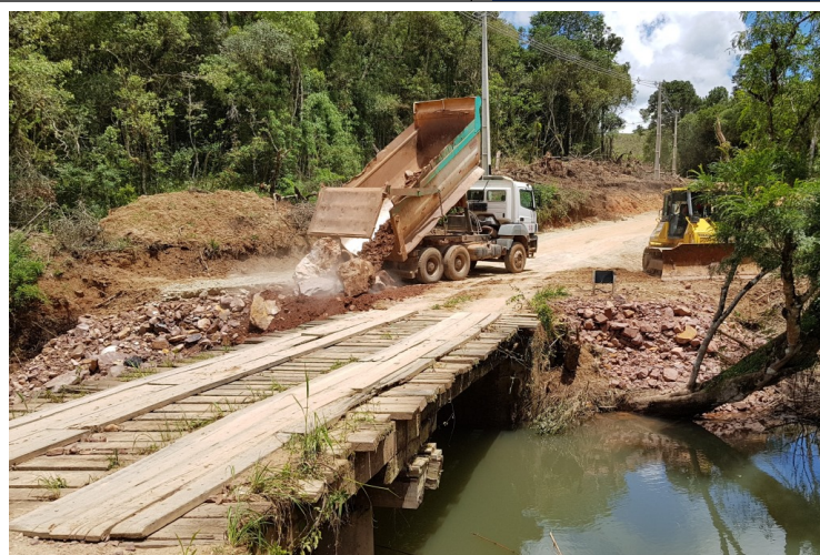
Figura 07: Início da obra de reforço da ponte da estrada de acesso
