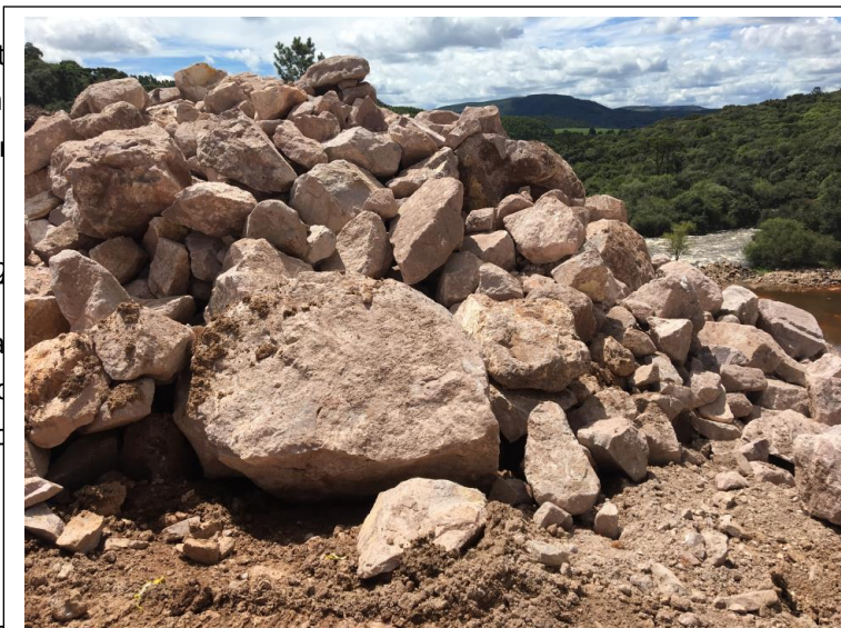
Figura 05: Rochas estocadas para proteção de locais de risco (depressões)
