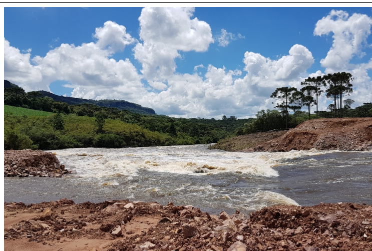
Figura 01: Precipitações elevaram vazão e afetaram o ritmo da Obra
