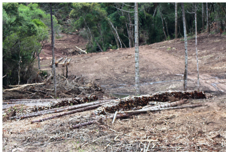
Figura 10: Madeira enleirada no local do canal, aguardando transporte
