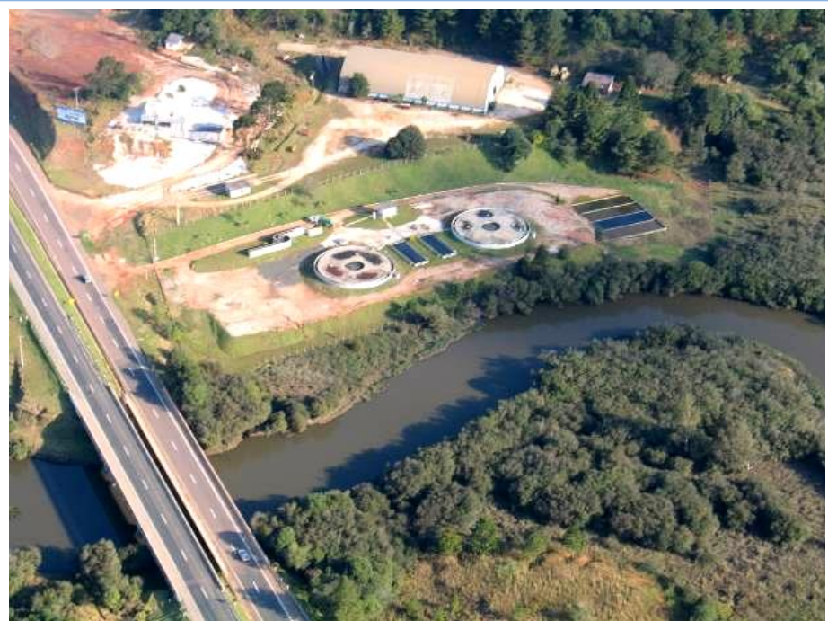
Figura 29. ETE da SANEPAR dilui efluentes no rio
