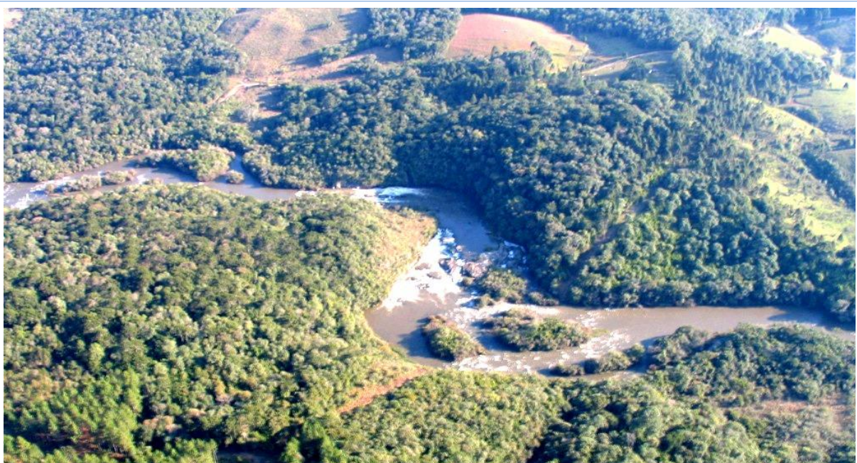
Figura 52 Vista aérea da área da PCH PULO
